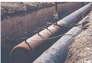
■ Druckprüfung, z. B. von Pipelines
