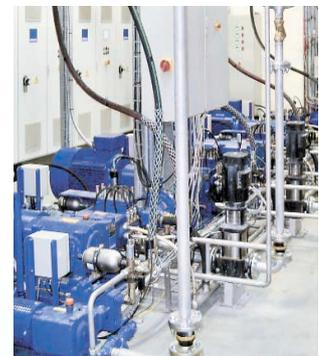
▲ Vier gekoppelte Aggregate zur Tankwagen-reinigung
